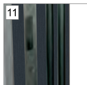
Przegroda termiczna, dwie uszczelki w ościeżnicy
