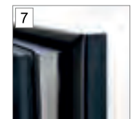
Przegroda termiczna, dwie uszczelki w skrzydle
