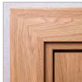
standardowe łączenie opasek pod kątem 45°
