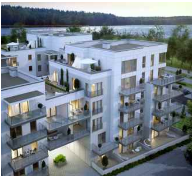
Obiekt: Apartamenty Marina w Ełku Inwestor: Rutkowski Development Sp.J.
