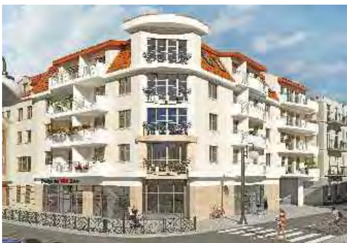
Obiekt: Kamienica Pan Tadeusz w Ełku Inwestor: Dom Ełcki Morusiewicz Sp.J.
