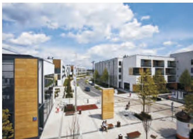
Obiekt: Osiedle Wilno w Warszawie Inwestor: Dom Development S.A.
