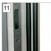
Przegroda termiczna, dwie uszczelki w ościeżnicy
