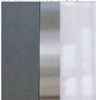
Zlicowanie ramki od strony wewnętrznej
