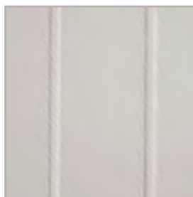
frezowanie na powierzchni skrzydła
