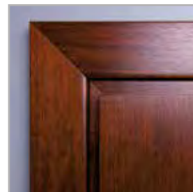
łączenie opasek pod kątem 45°
