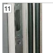
Przegroda termiczna, dwie uszczelki w ościeżnicy
