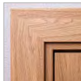
standardowe łączenie opasek pod kątem 45°
