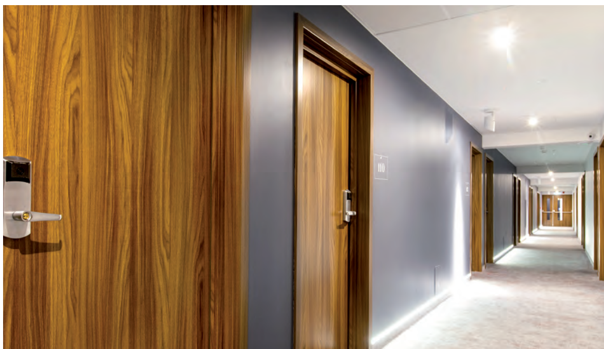
drzwi SR 37 dB, ościeżnica drewniana regulowana
