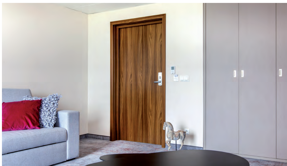
drzwi EI60 PLUS, ościeżnica drewniana regulowana
