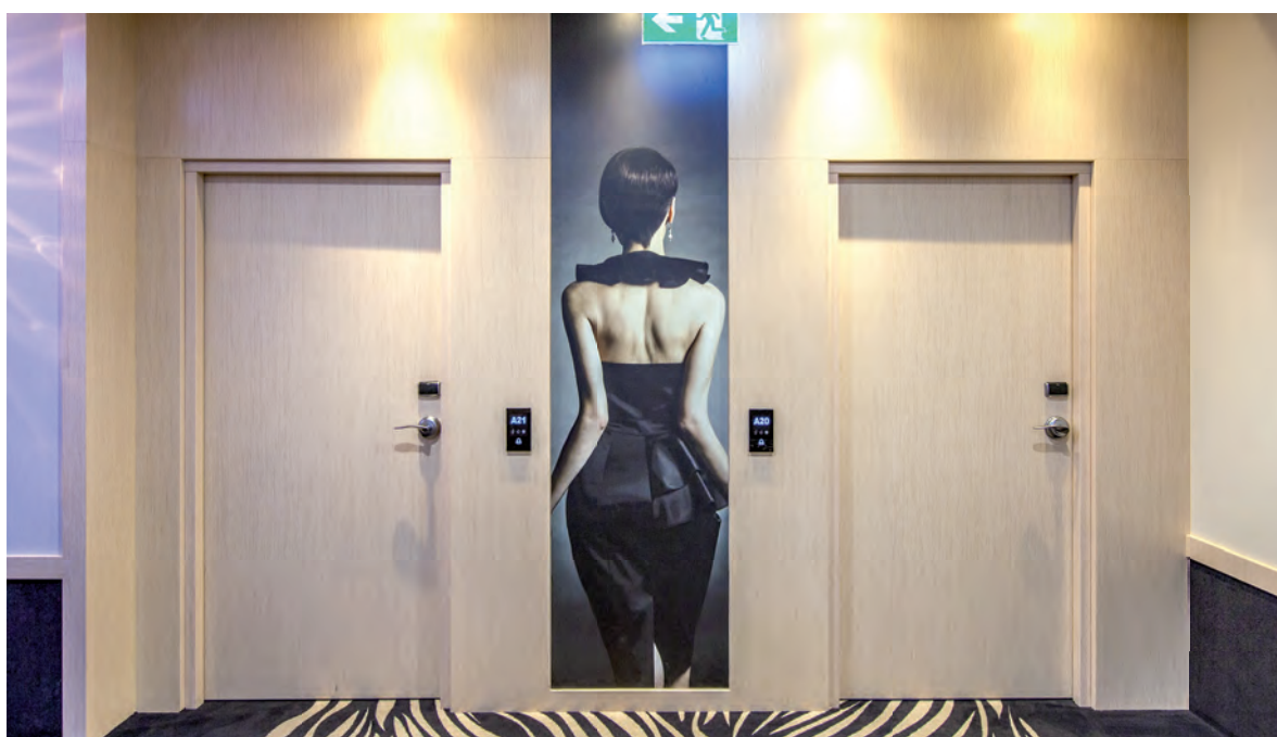
drzwi przeciwpożarowe FR EI30, ościeżnica stała drewniana
