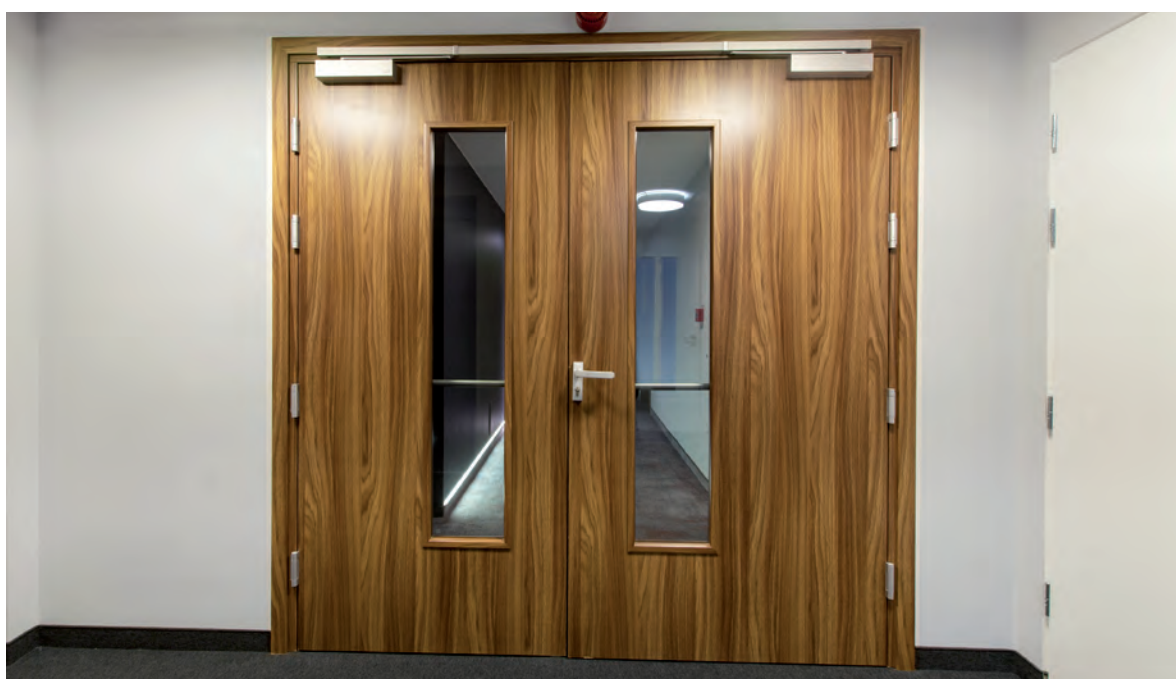
drzwi przeciwpożarowe FR EI30, ościeżnica stała drewniana
