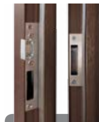
otwory zaczepowe ościeżnicy aluminiowej
